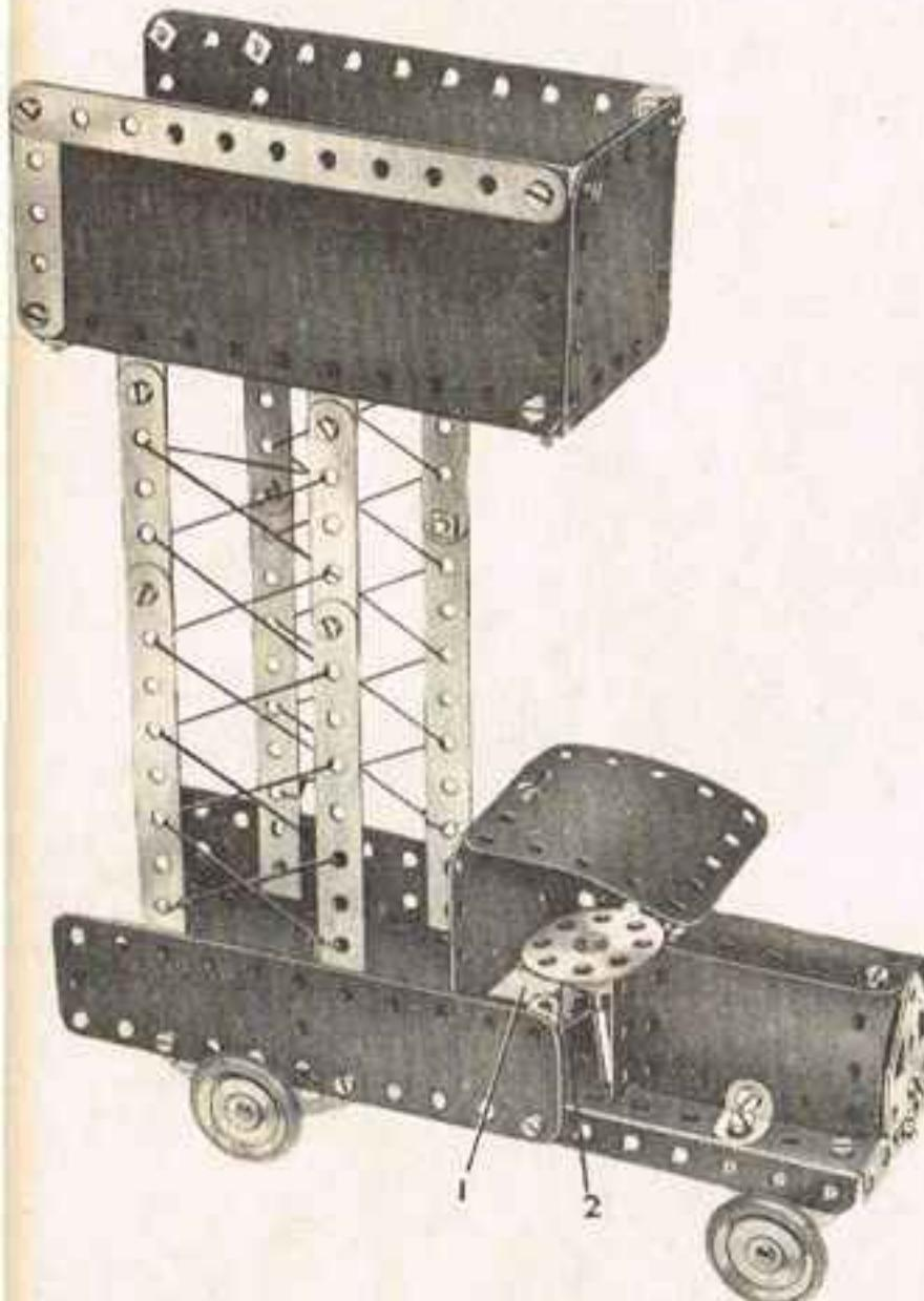
Une chape 1 est boulonnée dans une position horizontale au centre de la plaque à rebords et une bande incurvée de 6 cm. est boulonnée à son sommet pour former le siège. Une équerre renversée 2 est fixée ensuite dans un des trous allongés de la bande incurvée afin de servir de support à la tringle portant la roue barillet.
