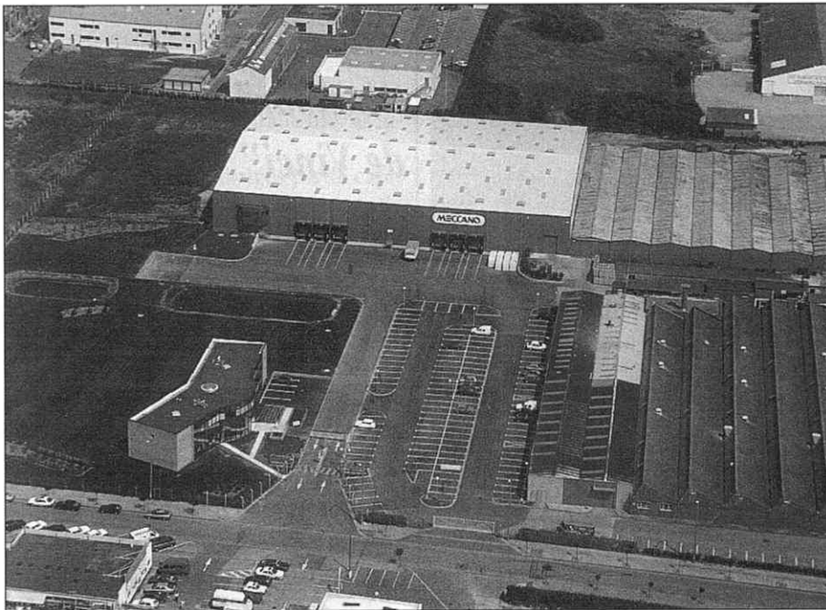
Vue générale de l'usine de Calais en 1995.
