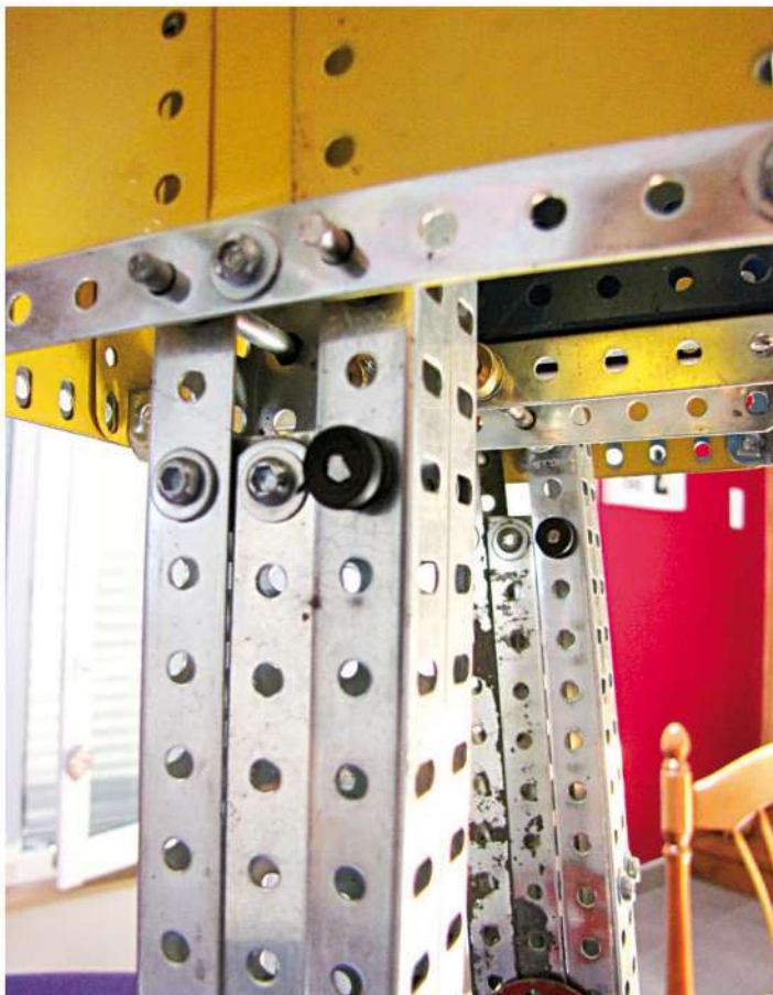
Fig. 2 Liaison corps et jambe, articulation du parallélogramme : de droite à gauche les bagues caoutchouc et les deux boulons munis de contre écrous
