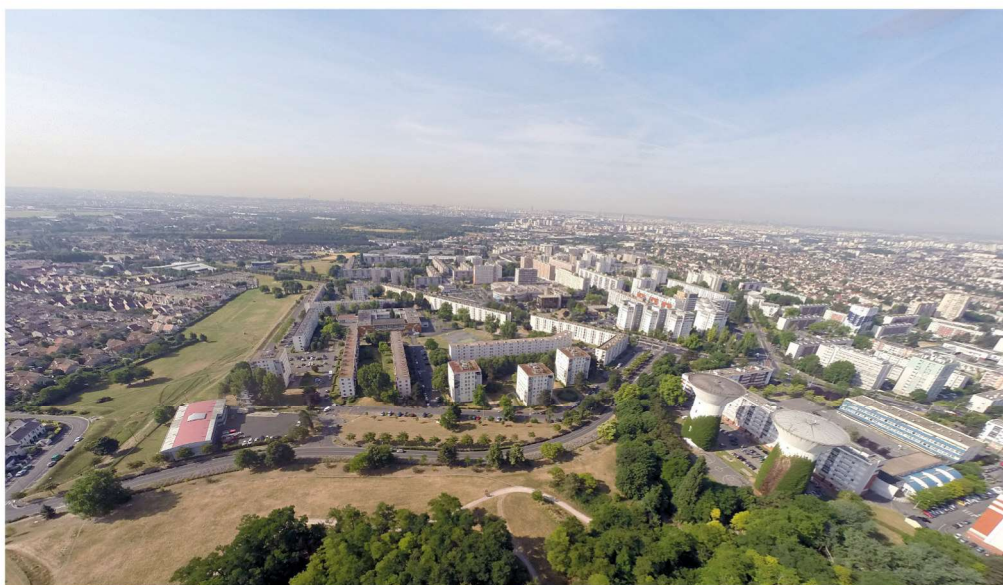
Fig. 1 Garges-lès-Gonesse vue du ciel
