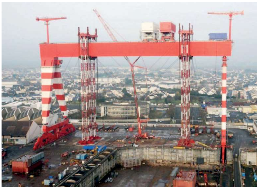
Fig. 1 Déc. 2013 : STX France achève le montage du très grand portique ( Photo Mer et Marine)
