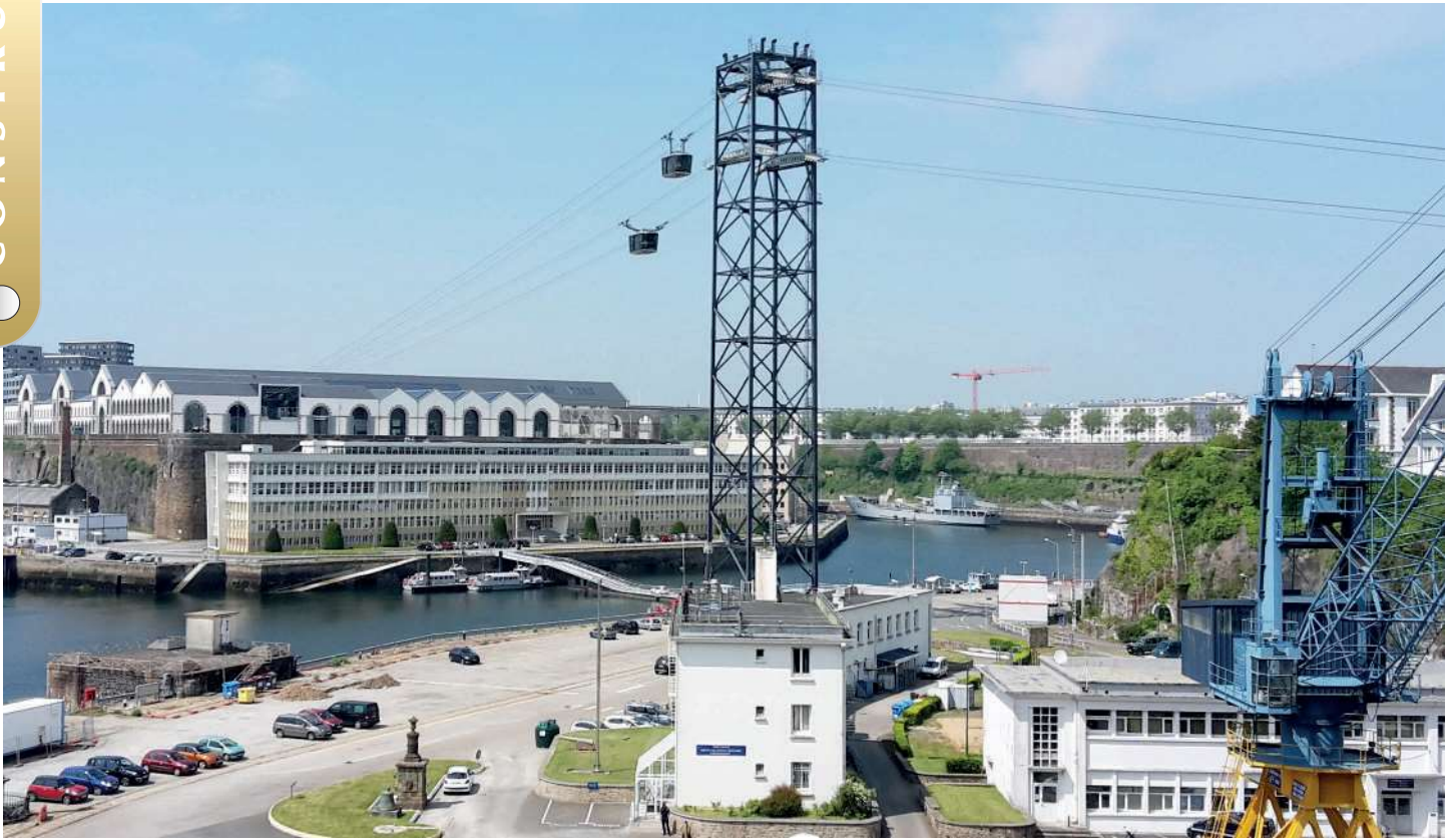
Fig. 1 Vue d'ensemble du téléphérique
