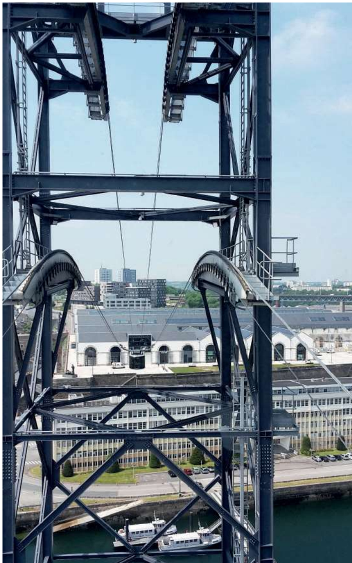
Fig. 4 Passages pour les cabines sur le pylône
