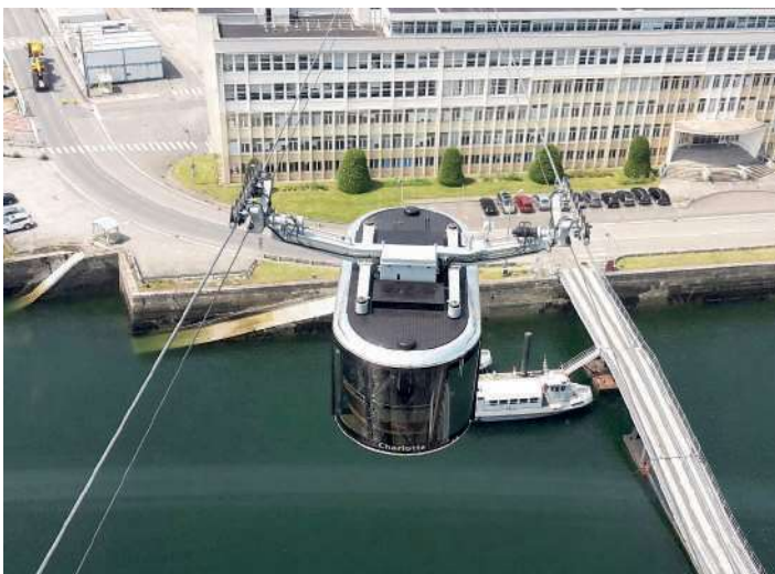
Fig. 2 Cabine basse vue depuis la cabine haute
