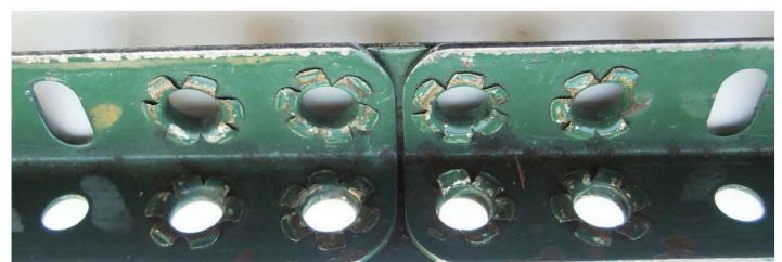
Fig. 4 Gros plan des rivetages, coté intérieur
