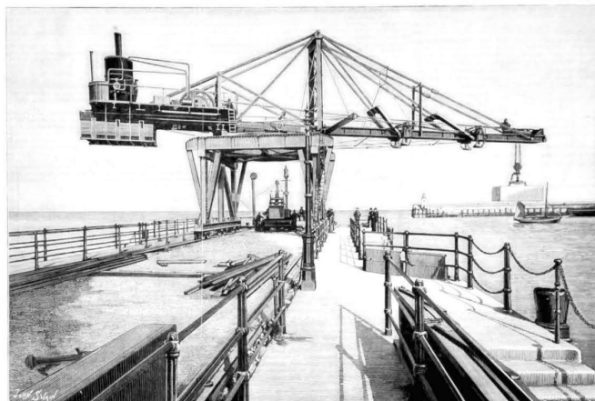
Fig. 1 – La grue Hercules
