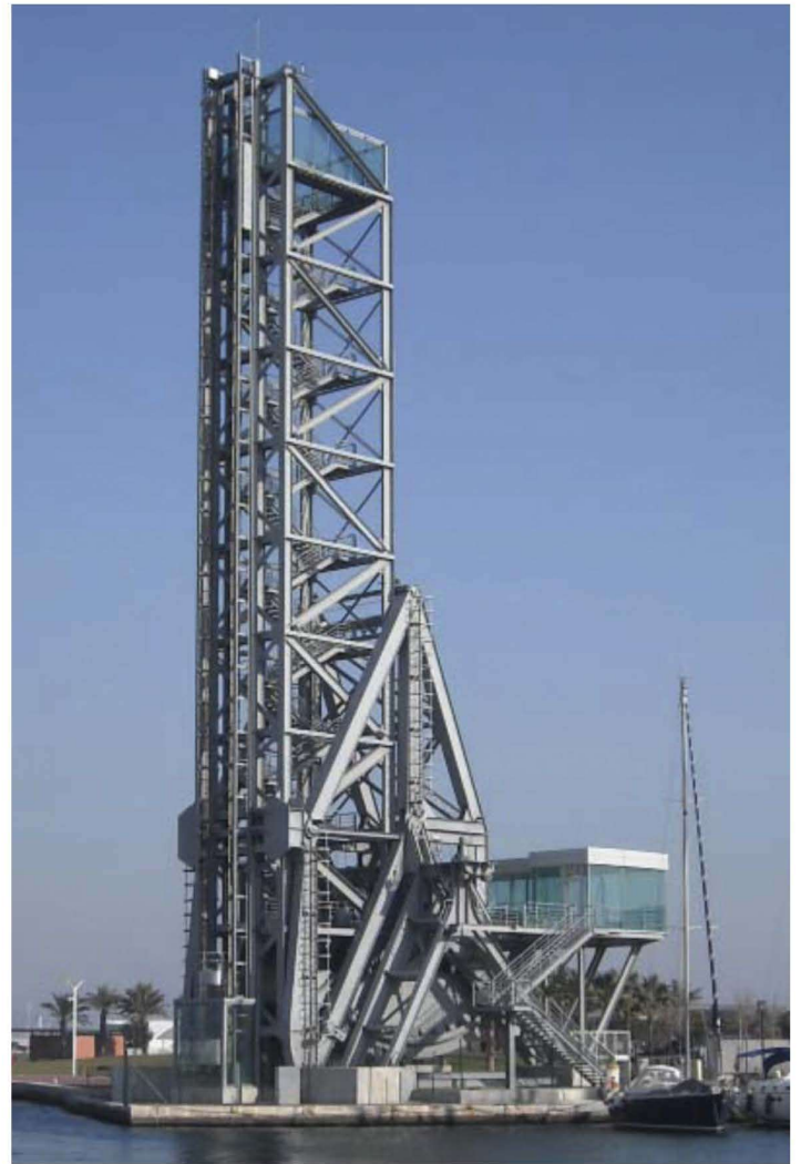
Fig. 1 Le vrai pont levant de La Seyne-sur-Mer Aujourd'hui ouvert au public et inscrit à l'Inventaire Supplémentaire des Monuments Historiques. La grande verrière à l'arrière abrite l'emplacement des mécanismes de manoeuvre. Un ascenseur situé au tablier permet au public à mobilité réduite d'accéder à la plateforme d'observation située à 45 m de hauteur.
